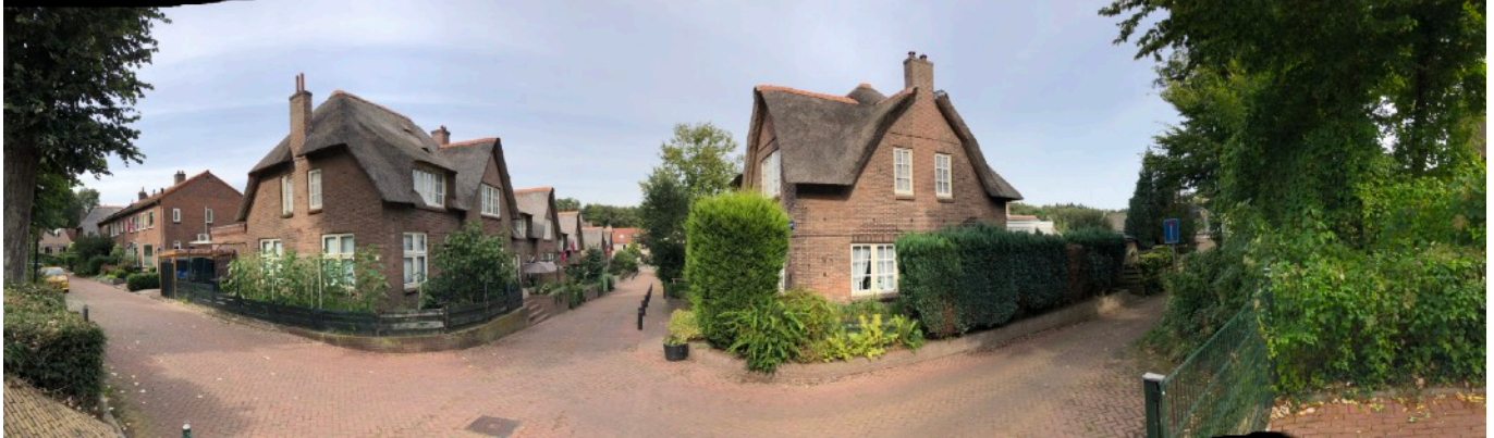
Fabrieksdorp Heveadorp in Renkum, gebouwd in opdracht van de eigenaar van de rubberfabriek Hevea.
